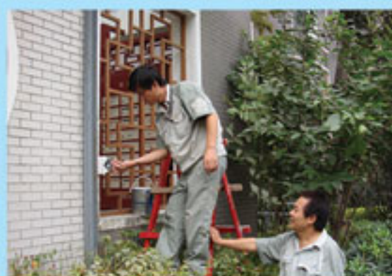
维修工正在工作
